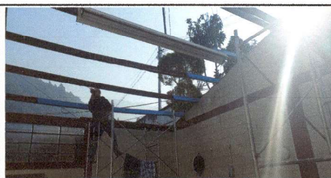
Foto 6: sustitucion de lámina
