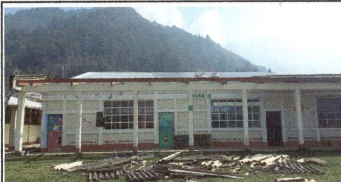
Foto1: sustitucion de lámina
