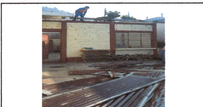
Foto 5: sustitucion de lámina
