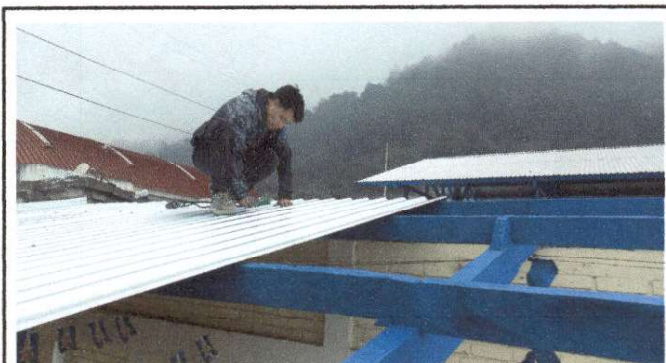
Foto 3: sustitucion de lámina
