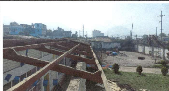
Foto 2: sustitucion de lámina
