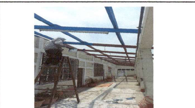
Foto 4: sustitucion de lámina
